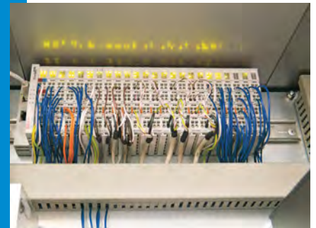
I/O – модуль ввода/вывода (EtherCAT)
