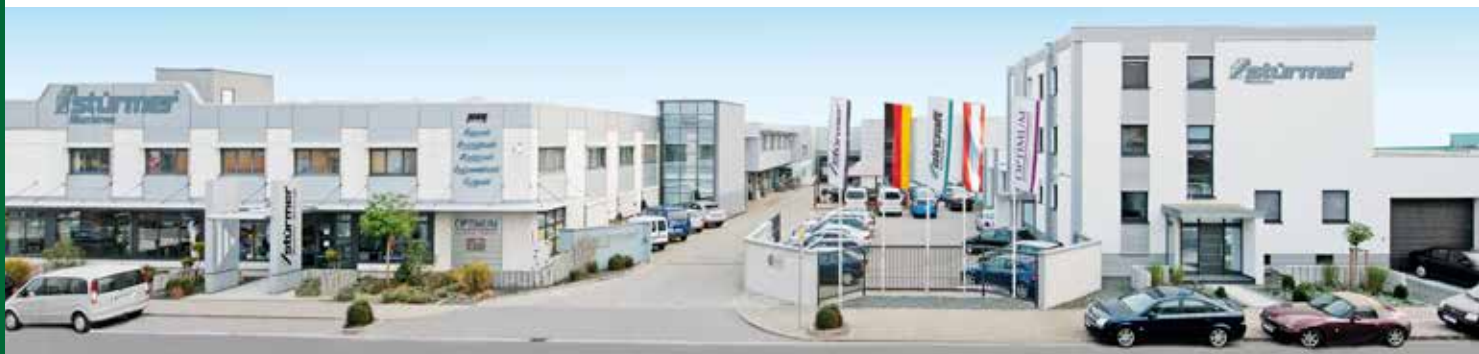
Главный офис и сервисный центр в Германии, Хальштадт / Бамберг
